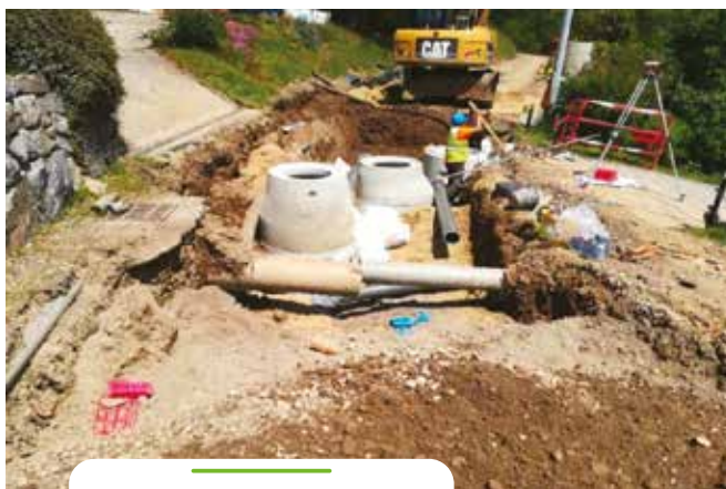
Travaux Rue des Maquisards à Willer-Sur-Thur
