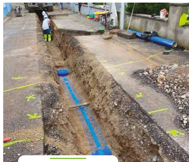
Travaux Rue des Vignes à Cernay
