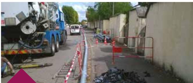
*Chantier de curage du réseau d'assainissement avec by-pass rue des Fabriques à Cernay*
